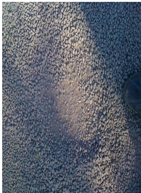
Ejemplo de una superficie permeable deshilachada
