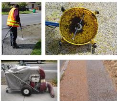
Lavado por presión y aspiración
