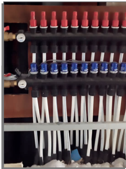
Colector geotérmico.
