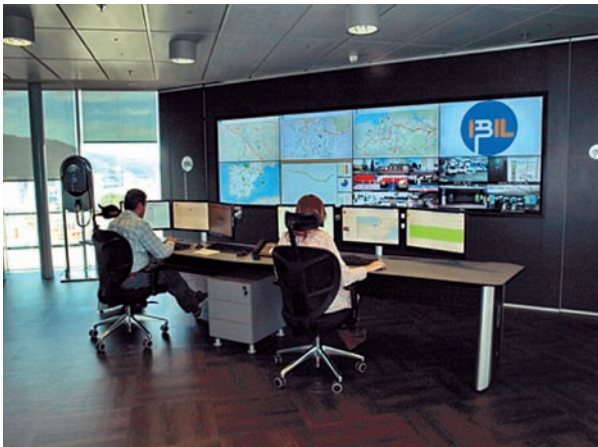
Figura 3. Centro de control de la infraestructura de recarga de IBIL.
