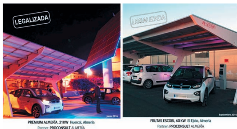
Figura 9. Marquesinas con fotovoltaica con postes de recarga para VE en autoconsumo.
