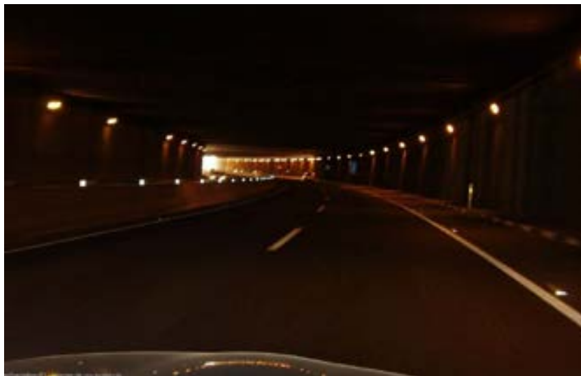
Figura 8.2. Interior del túnel.
