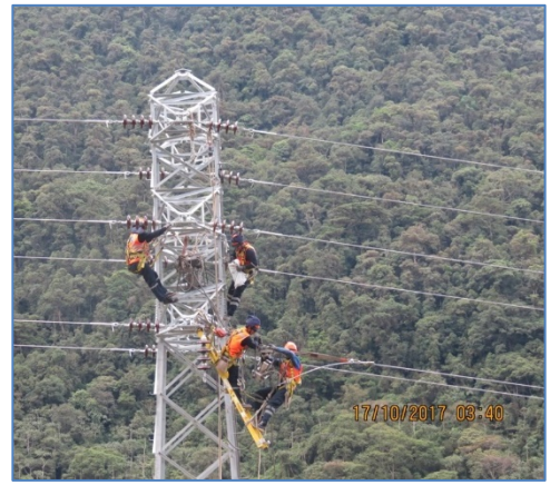
Maniobra de tensado de conductores 33 kV
