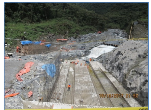
Construcción de dos naves desarenadoras
