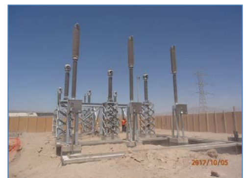
Montaje electromecánico de la S.E. Poroma
