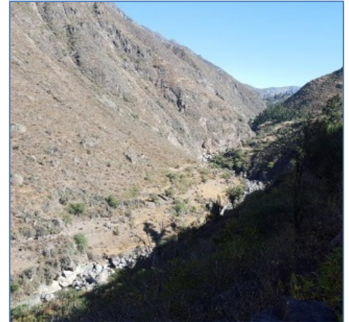
Primer tramo del Canal de Conducción
