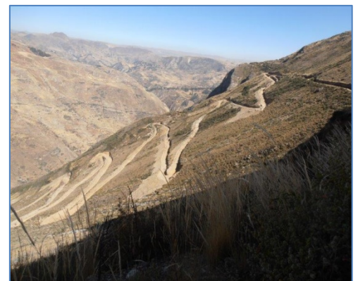
Camino de acceso a la Casa de Máquinas
