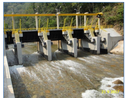
Vista Desarenador hacia aguas abajo del río Huatziroki
