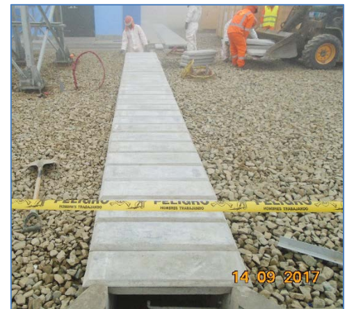
Colocación de tapas de concreto fabricadas en obra
