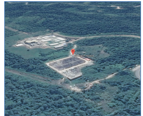
S.E. Aguaytía existente
