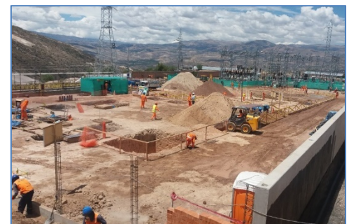
S.E. Mollepata: obras civiles
