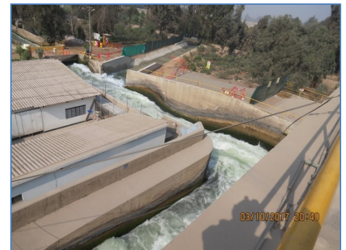
Canal Temporal construido
