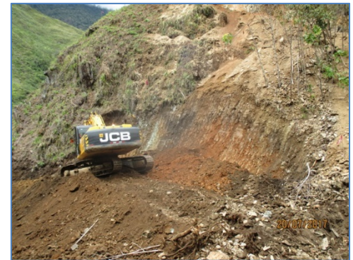
Excavación de Casa de Máquinas
