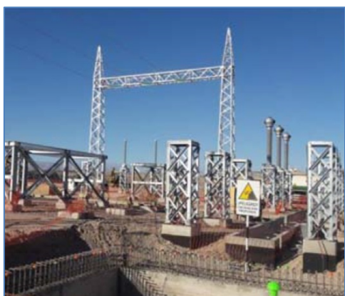
Montaje de estructuras y equipos de patio
