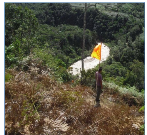
Trabajos de replanteo de la L.T. (Vértice V1)
