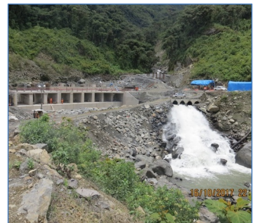
Bocatoma secundaria de 9 compuertas
