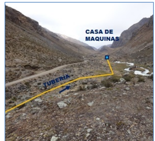
Casa de Máquinas
