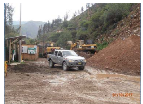
Área donde se construirá la S.E. Santa Lorenza
