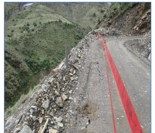
Replanteo de trazo topográfico
