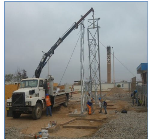
Montaje pórtico S.E. Parque Industrial
