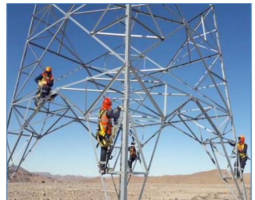
Montaje de torre de la L.T. 220 kV Rubí - Montalvo
