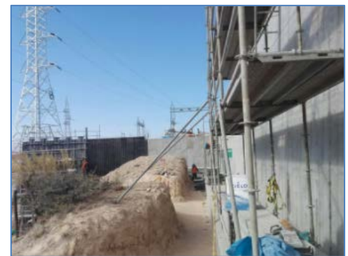
S.E. Mollepata: muro de contención
