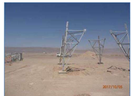
Montaje de Torre N° 1
