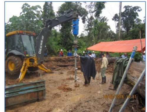
Prueba de pilotes helicoidales
