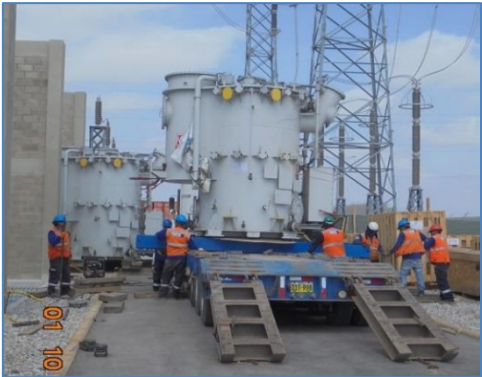
Descarga de reactores
