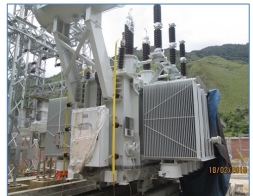
Montaje del Transformador de Potencia 55 MVA
