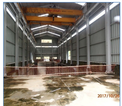
Casa de Máquinas
