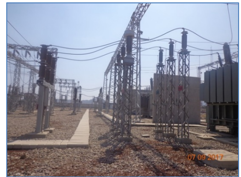
S.E. Guadalupe: cambio de configuración en 60 kV de simple a doble barra
