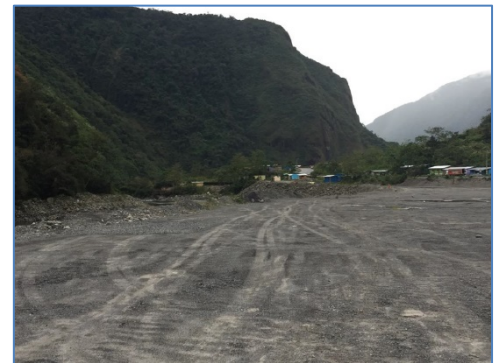
Plataforma en zona de Captación de Reservorio
