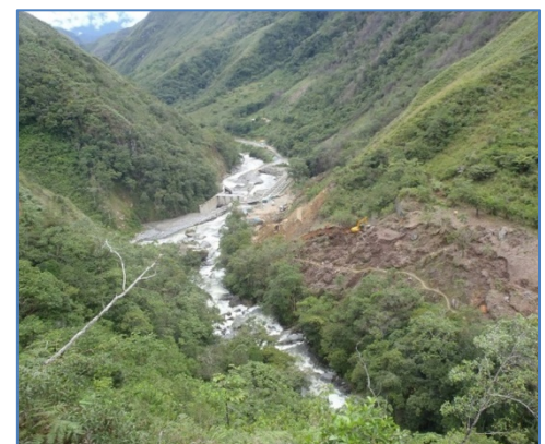
Caminos: Inicio de obras en tramo 1
