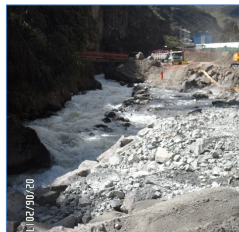
Movimiento de tierras para construir Desarenador
