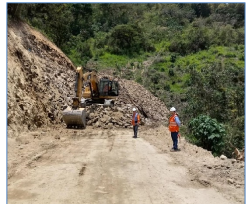
Excavación de plataforma de Canal de Conducción
