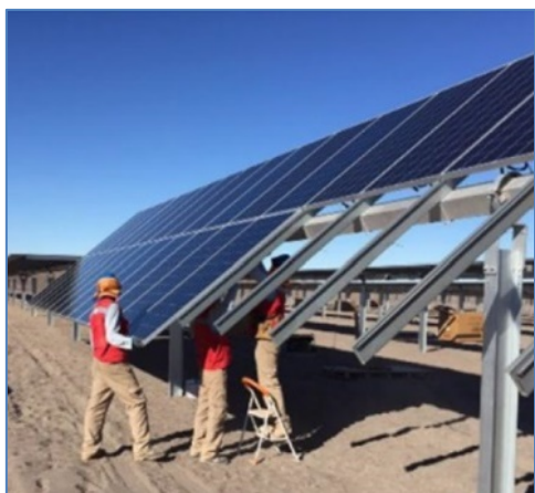
Montaje de paneles
