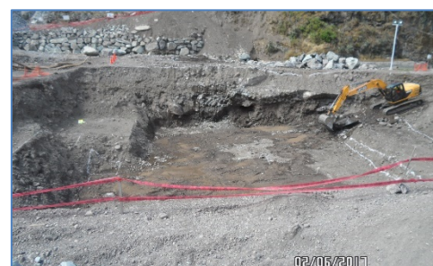
Trabajos de excavación en Casa de Máquinas
