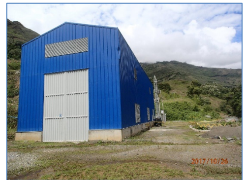
Casa de Máquinas
