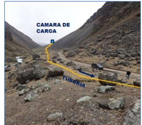
Cámara de Carga
