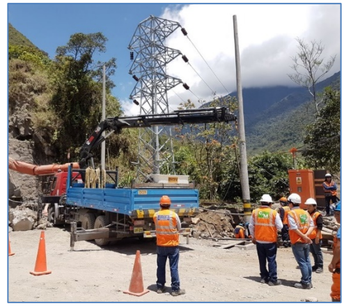
Montaje de poste de concreto – Línea de 33 kV
