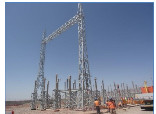
Montaje electromecánico de la S.E. Flamenco
