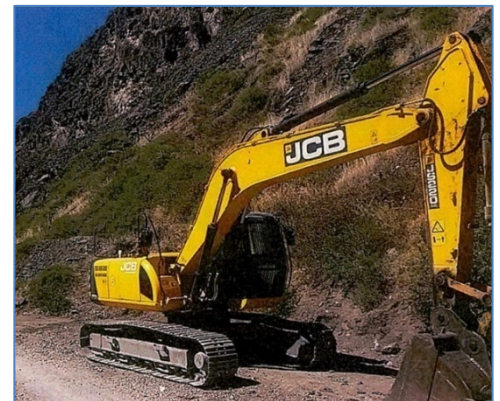
Movilización de equipos
