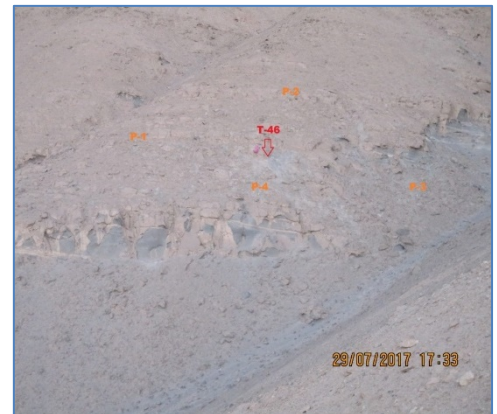
Trabajos de replanteo
