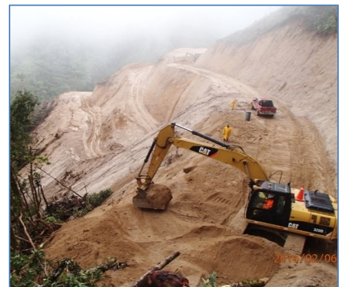
Apertura de trocha de acceso a Casa de Máquinas
