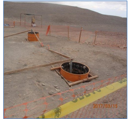
Bases de soporte de torres de L.T. Rubí - Montalvo
