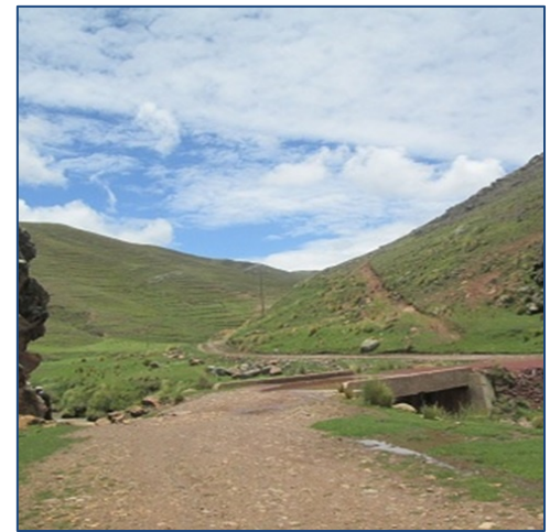
Zona de Presa, río Acco Acco
