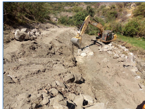
Construcción de vías de acceso
