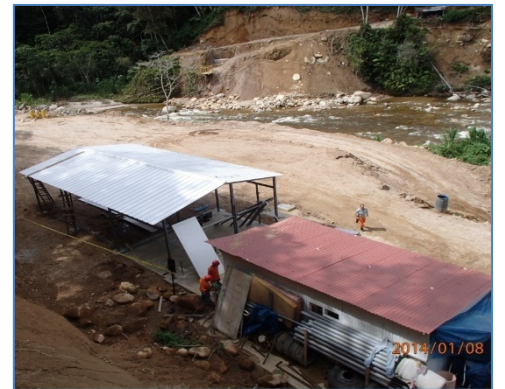
Construcción de campamento provisional
