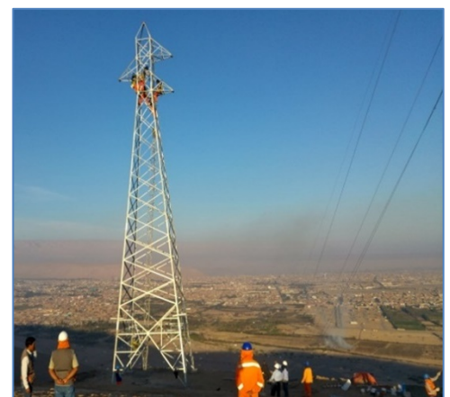
Montaje de torres de L.T. de 66 kV
