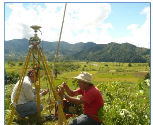
Zona de Captación - trabajos topográficos
