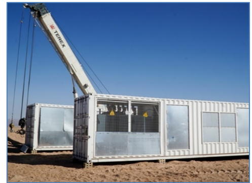
Inversores en sitio
