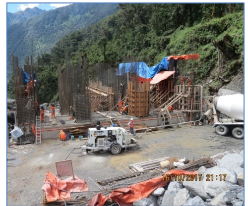
Armaduras de pedestales de compuertas radiales
