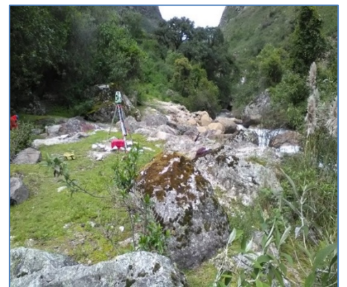
Replanteo de trazo topográfico
