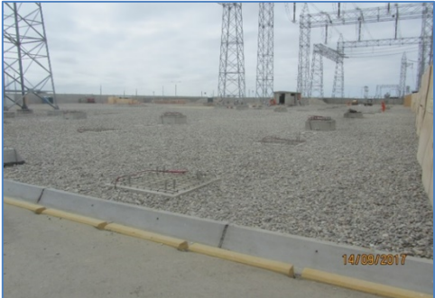
Nivelación de grava en patio de equipos de 500 kV
