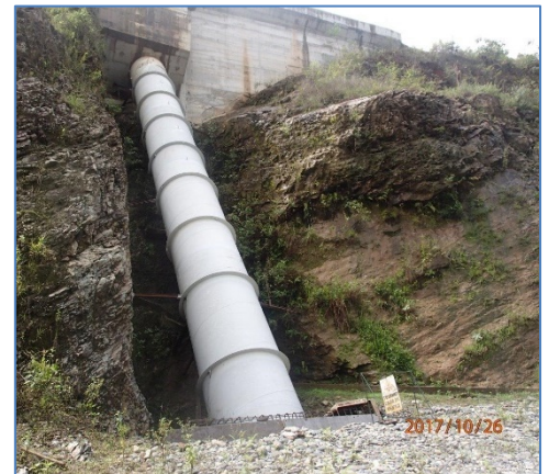
Tubería Forzada
