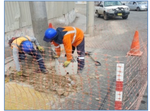
Instalación de postes de C.A.C. para la red primaria
