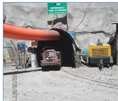
Trabajos en el Túnel de Entrada
