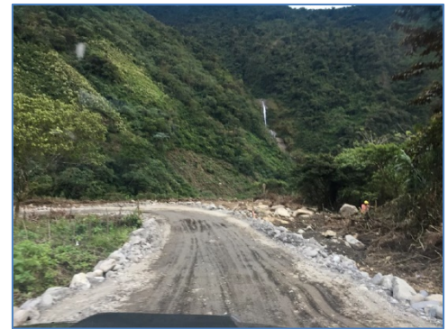
Camino de acceso para campamentos
