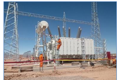
Montaje de pararrayos 138 kV – S.E. San Román
