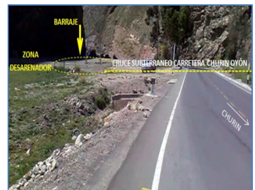
Cruce del Ducto Subterráneo de la C.H. Viroc
