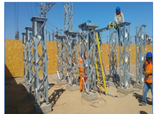
Montaje soportes S.E. Parque Industrial
