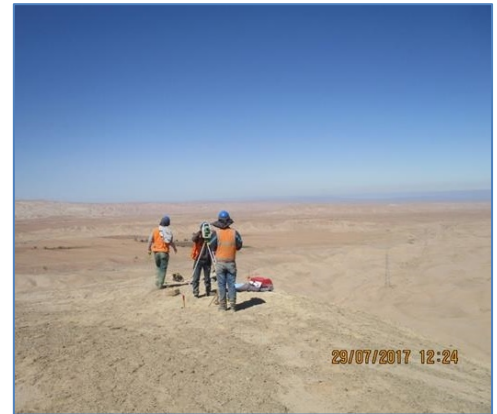
Trabajos de replanteo
