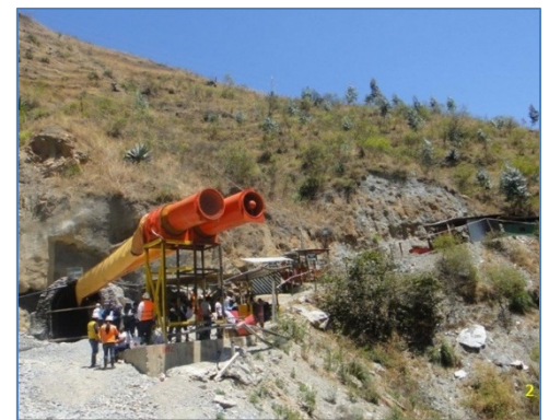
Ventana N° 2 del Túnel de Aducción
