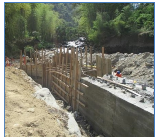
Bocatoma – Encofrado y vaciado de concreto en dique
