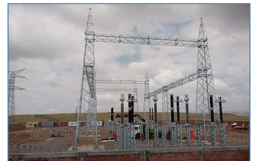
Avance de obras S.E. Puno
