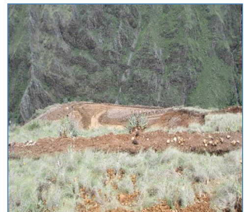
Replanteo de trazo topográfico
