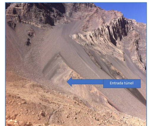
Entrada al Túnel de Conducción
