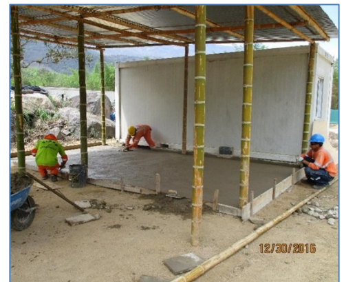
Instalación de campamento
