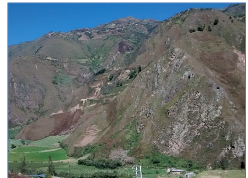
Zona de entrada al Túnel de Conducción
