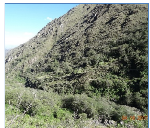
Vista panorámica de línea de conducción
