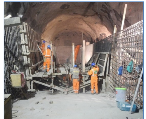
Armadura y encofrado de muros – Cámara de Carga
