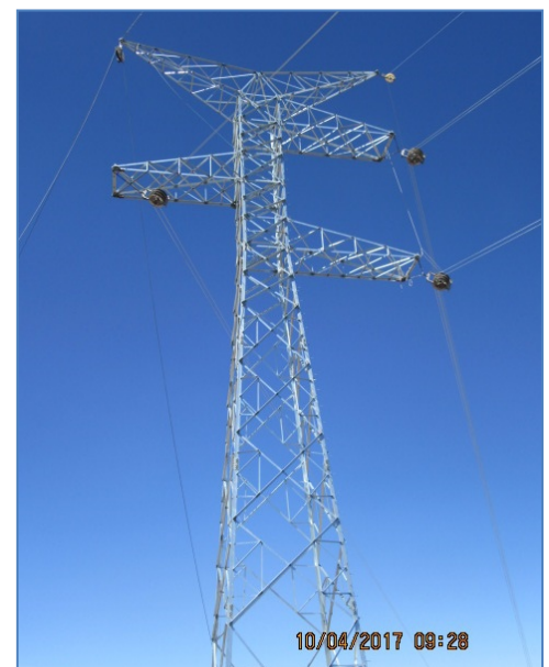
Tensado de conductor inferior en ángulo
