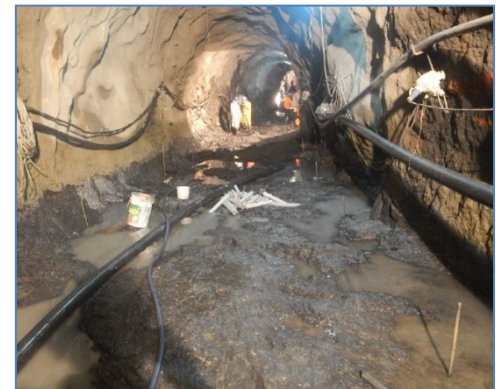
Limpieza y vaciado de solera – Túnel de Conducción
