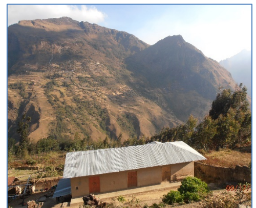
Zona de la Tubería Forzada
