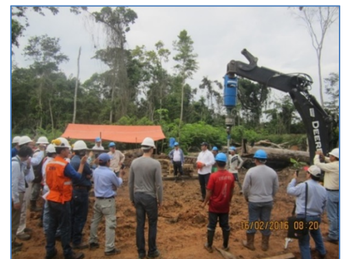
Prueba de pilotes helicoidales
