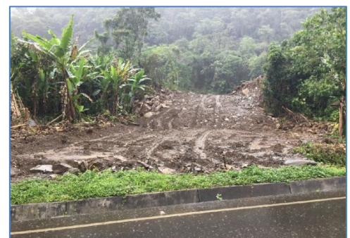
Camino de acceso a plataforma de Casa de Máquinas
