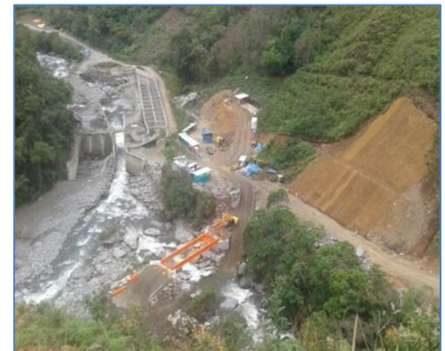
Reforzamiento en talud
