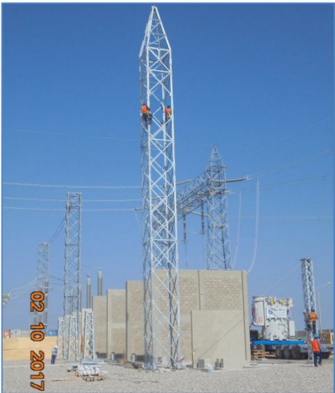
Montaje de columna de pórtico
