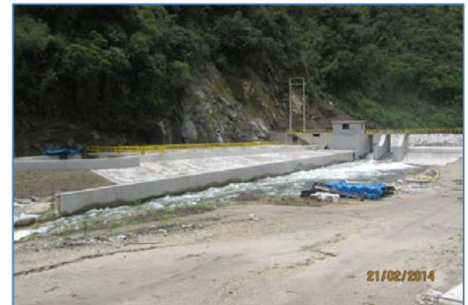
Vista de la Bocatoma
