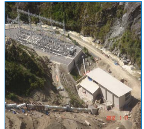
Casa de Máquinas y Tubería Forzada
