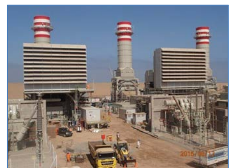
Vista de los turbogeneradores
