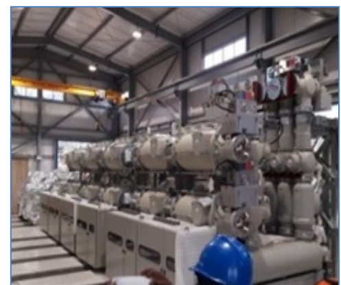
S.E. Friaspata: Instalación GIS
