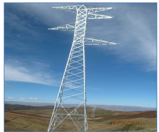
Vistas de Torres en la L.T.
