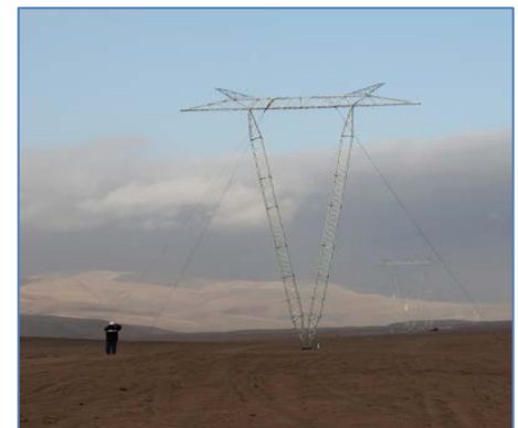
Torres tipo VSL Suspensión Atirantada (Ocoña – Montalvo)
