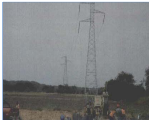
Estructura de la L.T concluida
