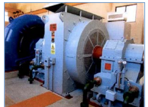
Grupo de Generación (Turbina Hidráulica Generador Eléctrico)
