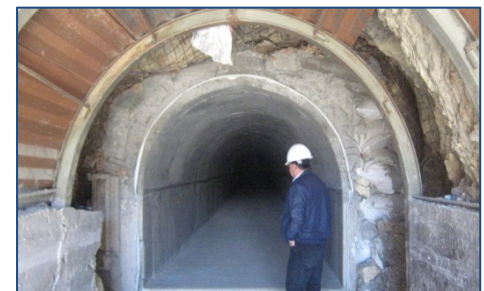
Vista del Túnel
