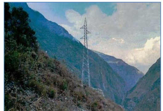
Montaje de Estructura E8 concluido
