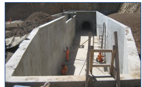
Acabados en la cámara de carga
