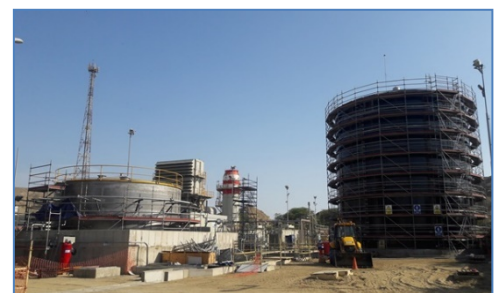
Tanque de transferencia de Diesel B5
