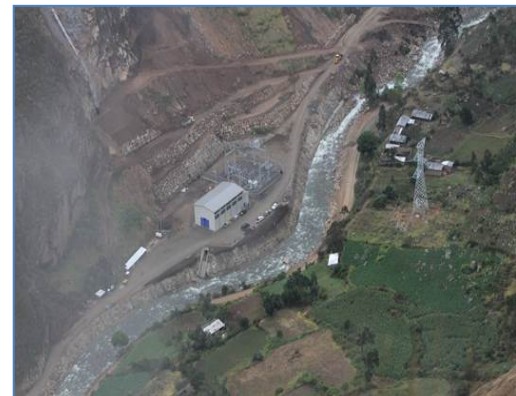
L.T. 220 kV SE Runatullo III – SE Concepción
