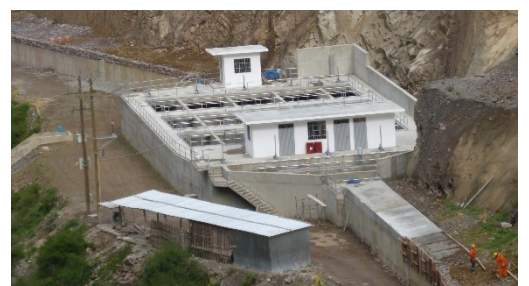
Vista Panorámica del Desarenador
