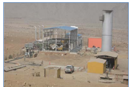
Central Termoeléctrica Huaycoloro
