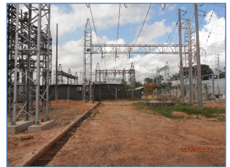
Vista de la Primera Torre
