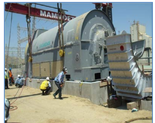
Montaje de Turbina a Gas y Generador
