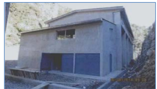
Construcción de la Casa de Máquinas
