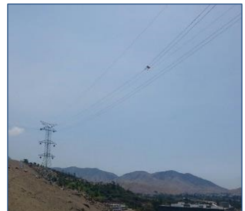
Tendido de conductor
