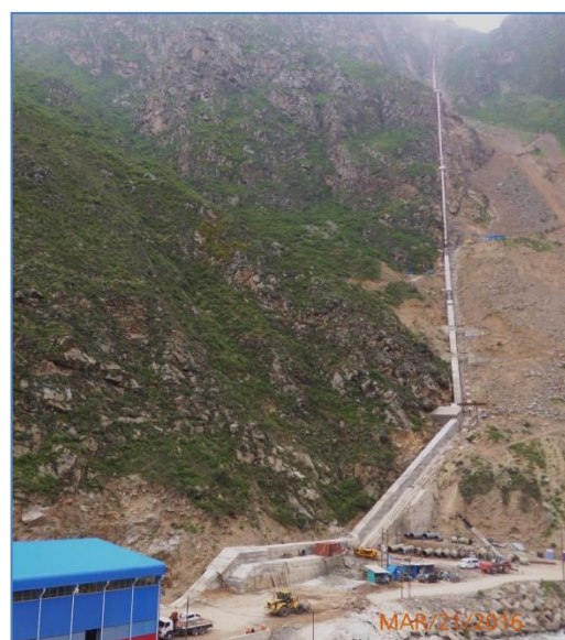
Tubería Forzada
