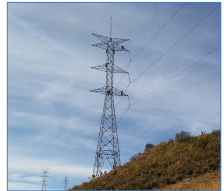
Torre 30, cambio de ménsulas de cable de guarda
