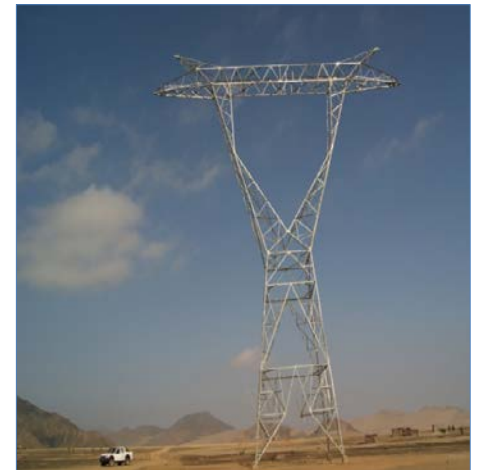
Torre Autosoportada 500 kv
