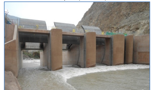
Presa Picunche- barraje móvil
