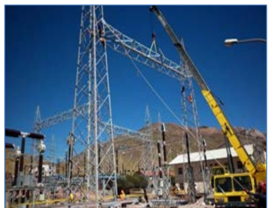
Montaje de una viga en Plataforma I SE Pomacocha
