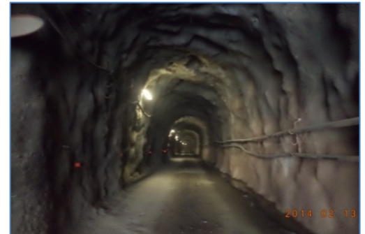
Túnel de Transferencia Huaura-Checras
