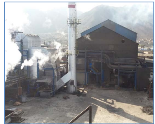
Vista panorámica de la planta industrial
