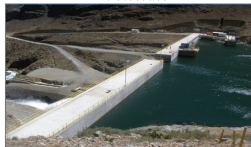
Presa Pallca y la BocATOMA
