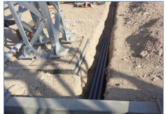
Trabajos en Subestación Marcona
