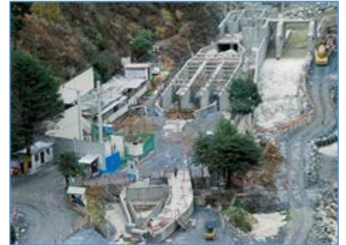
Barraje, Bocatoma, Desarenador y Canal de Conducción
