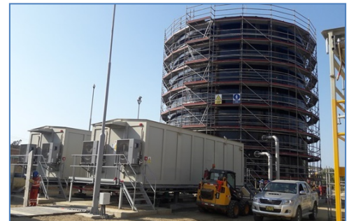
Avance de Obras
