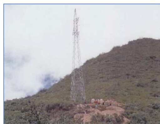
Vista de Torre TE-01
