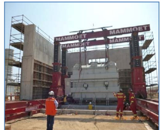
Montaje del Transformador de Potencia Concluido
