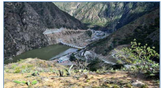
Vista panorámica del Embalse y de la Presa
