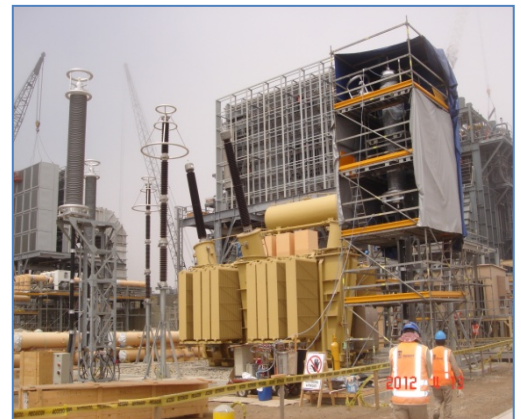
Montaje de Transformador de Potencia de T.G.
