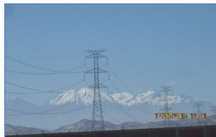
L.T. 220 kV San José – Cerro Verde
