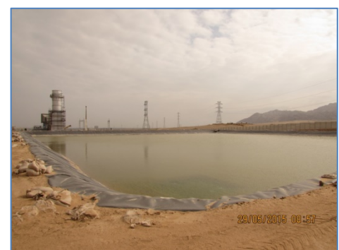
Balsa de evaporación
