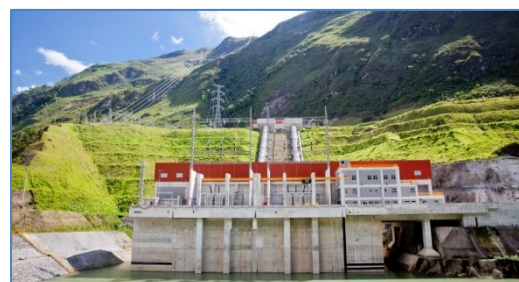
Casa de máquinas principal
