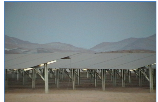
Instalación de Módulos Fotovoltaicos
