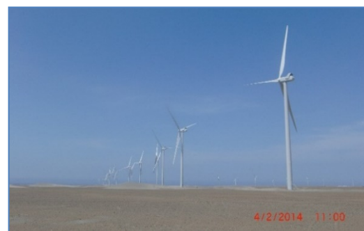
Vista de los Aerogeneradores montados
