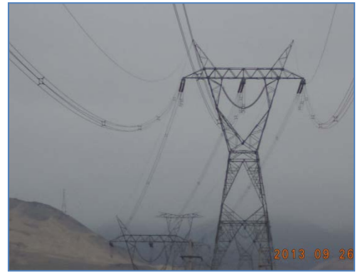
L.T. 500 kV S.E. Fénix – S.E. Chilca
