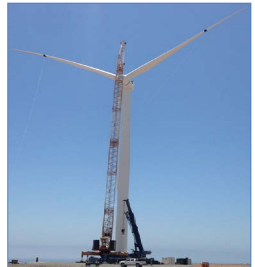
Montaje de Palas
