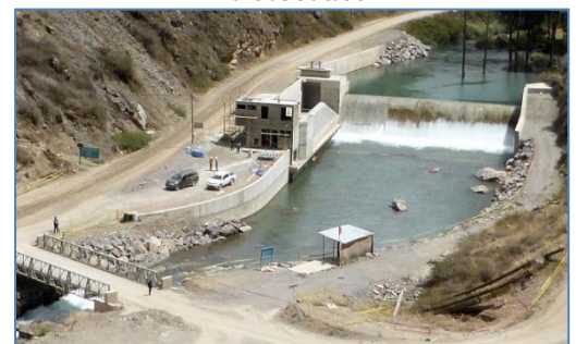
Vista Panorámica de la BocATOMA
