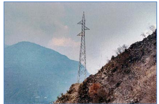
Montaje de Estructura E3 concluido
