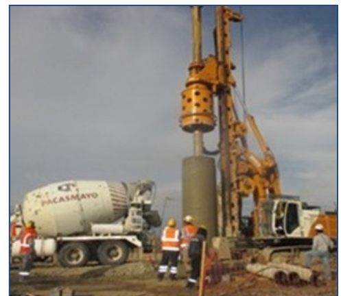
Vaciado de concreto para T08 (Hito d)
