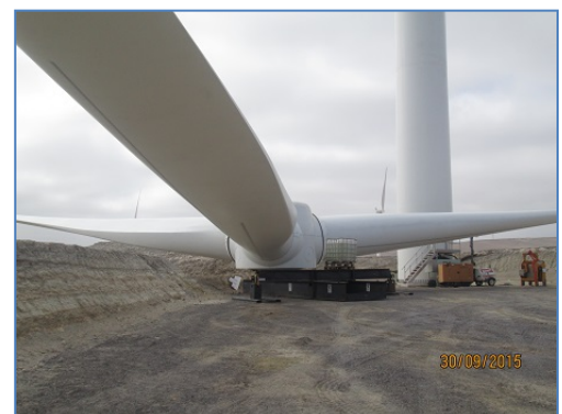
Montaje de Aspas
