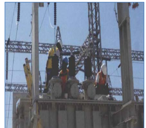
Montaje de bushing del Transformador de Potencia
