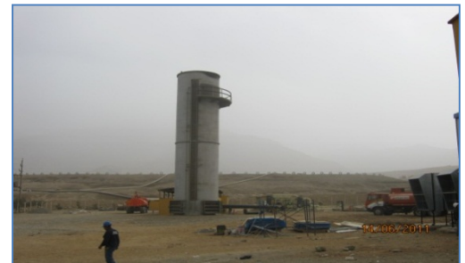
Quemador de Biogás
