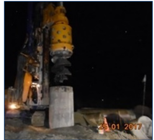
Perforación para estructura T08 (Hito d)
