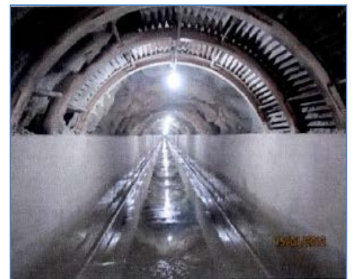
Túnel Huasahuasi I
