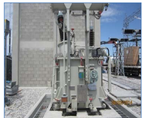
Reactor de PAT del neutro – Banco de reactores – 4 x 50 MVAR c/u
