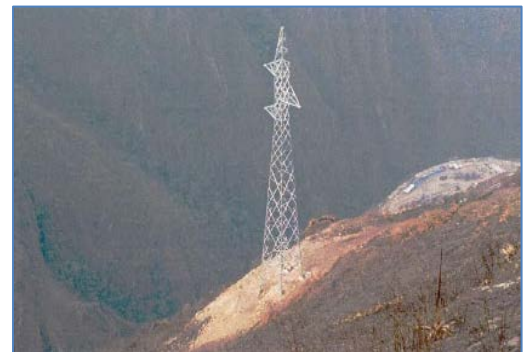
Montaje de Estructura metálica E4 concluido
