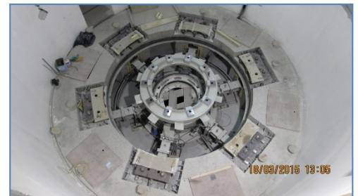
Trabajos previos al montaje del Generador N° 2
