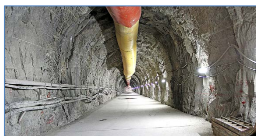
Túnel de Descarga
