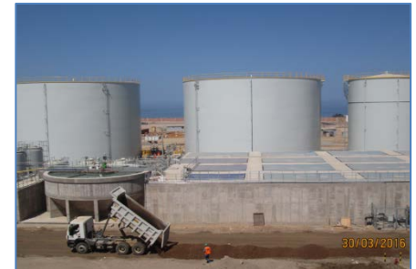
Tanque de Almacenamiento Combustible Diésel B5
