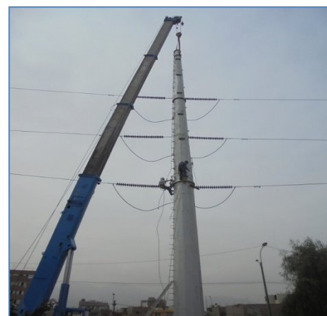
Montaje de Poste Metálico del 2do y 3er Cuerpo de la L-2246
