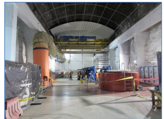
Casa de Máquinas (en caverna)
