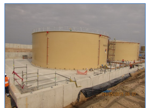
Tanques de almacenamiento de combustible Diésel B5
