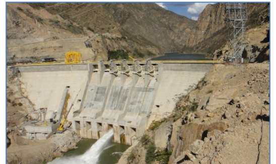
Vista posterior de la Presa
