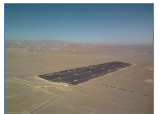
Vista panorámica de la central
