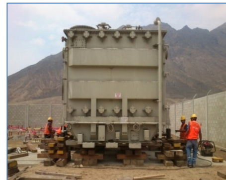
Montaje de Reactor de 40 MVAR (S.E. Trujillo)
