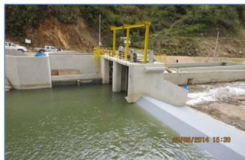
Bocatoma y Desarenador
