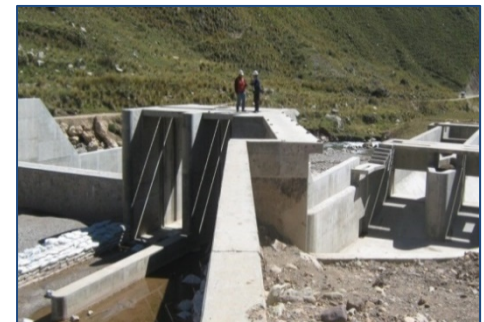
Vista panorámica Bocatoma
