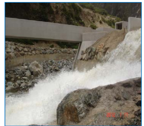
Puente Canal Huasahuasi II
