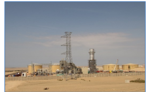
Vista panorámica de la central
