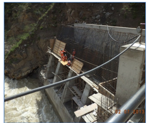
Vista Panorámica Captación, Ataguía
