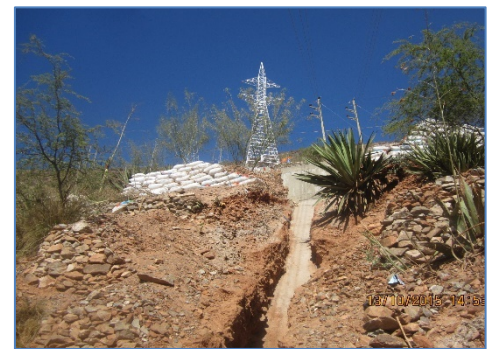
Buzón N° 8 y Torre N° 6 (Transición de Cable XLPE a Conductor Aéreo 138 kV), parte de la L.T. 138 kV Amarilis-Huánuco (L-1144)
