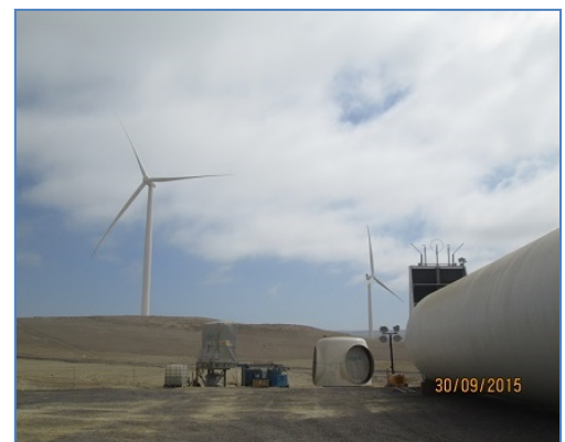
Vista de Aerogeneradores Instalados
