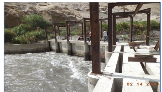
Obra de Captación
