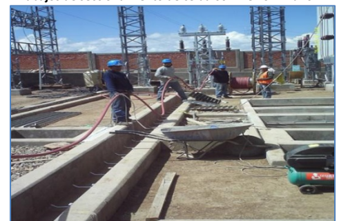
Tendido de cable de potencia 70 mm 2 Trafo T53-162 - Celda 22.9 kV en S.E. Puno
