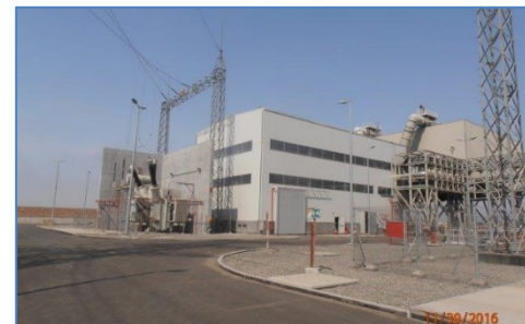
Nave de Turbina-Generador a Vapor
