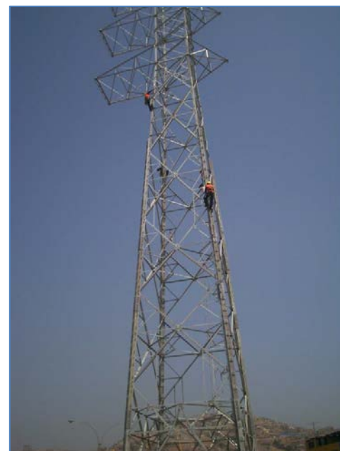
Montaje de Torre
