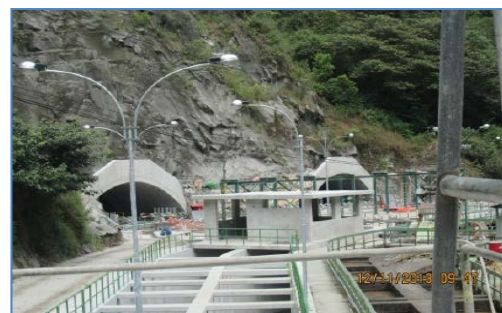
Vista de los Desarenadores
