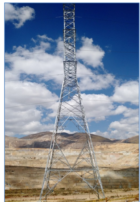
Torre T31N culminada y LT energizada
