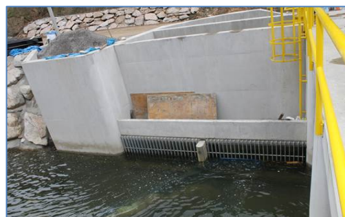
Ventana de captación
