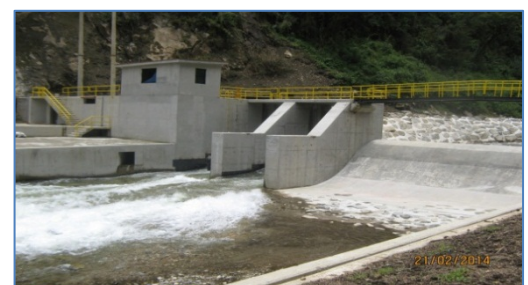
Barraje fijo y móvil de la Bocatoma
