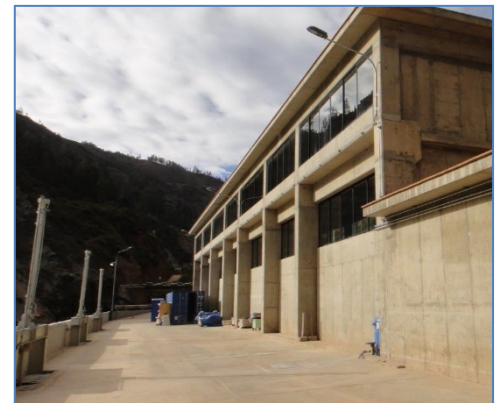
Casa de máquinas
