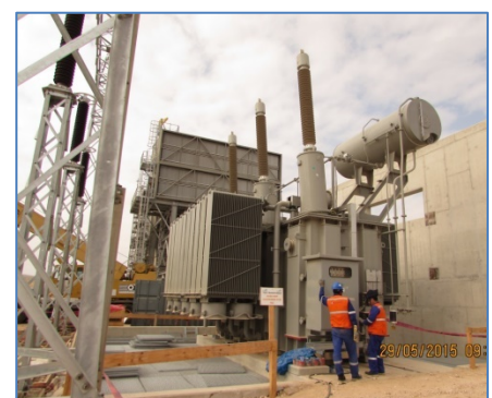
Montaje del Transformador de Potencia (S.E. Recka)
