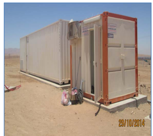
Casa de Control - P.S.F. Moquegua
