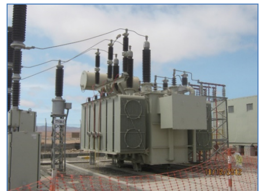
Transformador de Potencia de la S.E. Panamericana Solar
