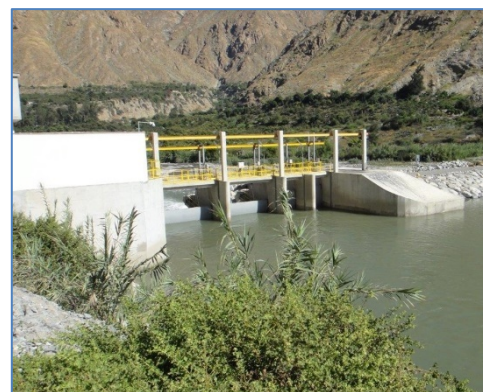
Vista de Bocatoma con sus compuertas radiales
