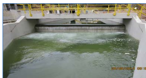
Vista del canal de conducción
