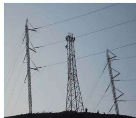
Desmontaje de Torre T44 de L-2246
