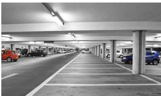
Imagen de la izquierda: 'manta de luz' CoreLine en un garaje generada por el haz de luz ancho. Imagen de la derecha: luz insuficiente y puntos oscuros como resultado de la sustitución de luminarias convencionales por luminarias con un haz de luz lambertiano.
