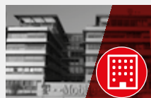
Terciario construcción Service & retail construction
