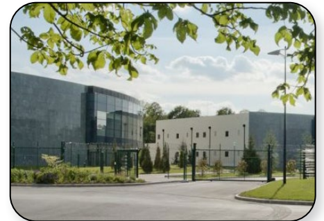
DATA4 France: Campus de Centros de Datos en Francia
