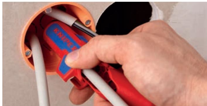
Dégainage d'un câble de données
