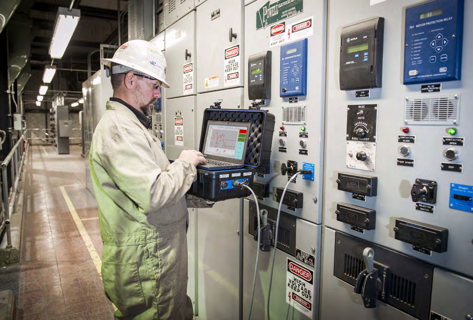
Un technicien utilisant un analyseur EXP4000 connecté à un port EP1000
