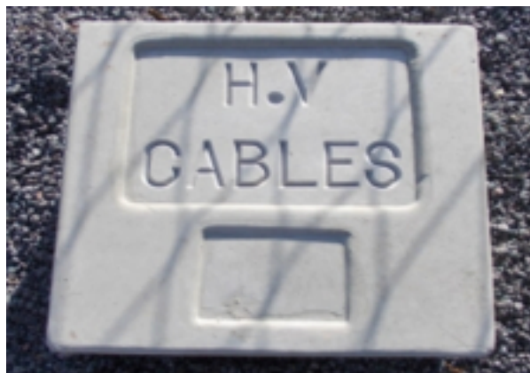
Figure 3 – Marquage de câble souterrain
