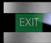
Segnalazione EXIT EXIT signal
