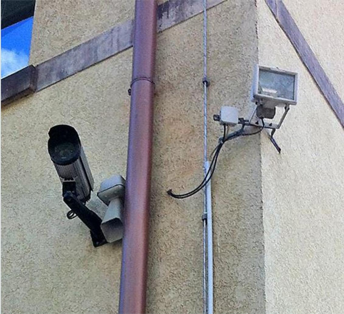
Il cavo del dispositivo di monitoraggio si incrocia con la calata
