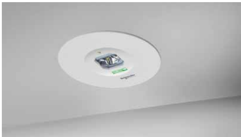
Installazione a controsoffitto
