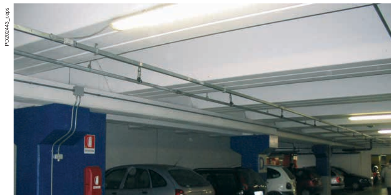
Condotto sbarre Canalis KBA per l'illuminazione con sprinkler vicini.
