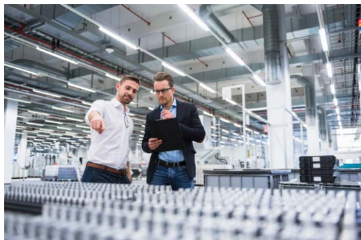
Figura 4. Esempio di illuminazione in un capannone
