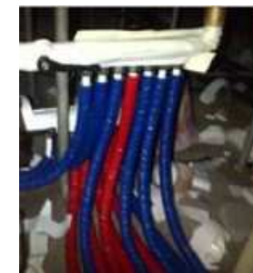
Collettore del modello e nella realtà
