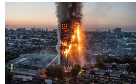
Incendio alla Grenfell Tower di Londra 87 vittime giugno 2017
