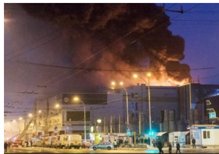
Incendio al centro commerciale Kemerovo (Russia) 64 vittime marzo 2018
