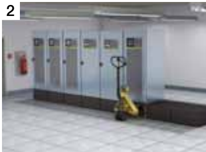
600 kW, modalità on-line a doppia conversione
