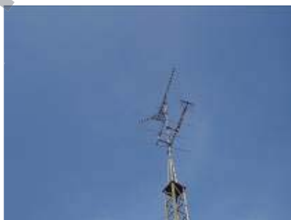
Figura 8.36 – . Esempio di parte aerea, per la ricezione di segnali radioelettrici, montata su un traliccio.
