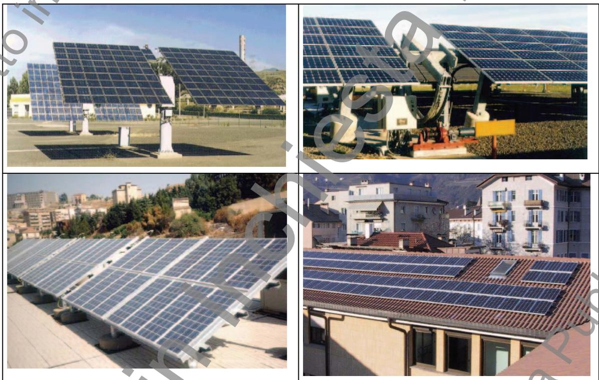
Figura 4.2 Varie tipologie di strutture di sostegno per moduli fotovoltaici: Inseguimento solare su due assi, inseguimento su un asse [1], struttura inclinata su cavalletti e struttura inclinata su falda
