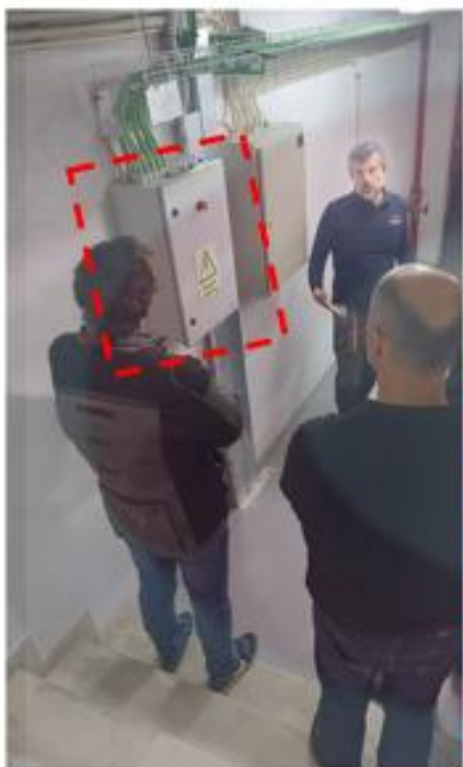
Dispositivo de corte automático com comando do DP (ex. contactores )
