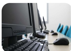
Escritórios, Data Centres: Iluminação LED, UPS, Climatização
