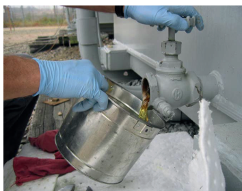
2 – Descarregar a válvula de drenagem, a tubagem e a seringa
