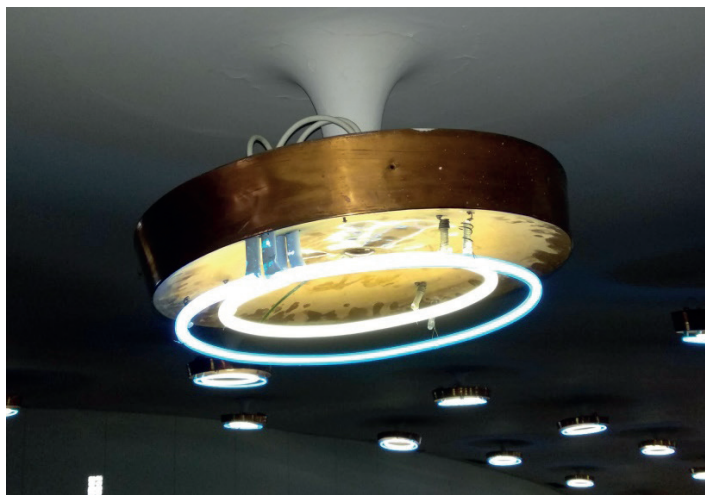
Figura 7. Luminária existente na sala principal que irá ser recuperada.
