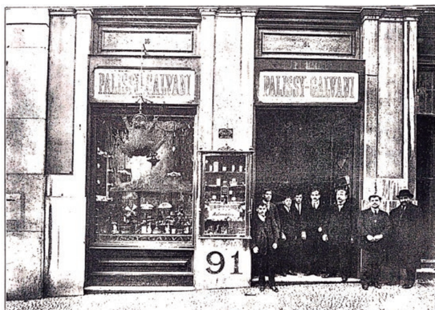
CASA PALISSY GALVANI — Exterior do estabelecimento
