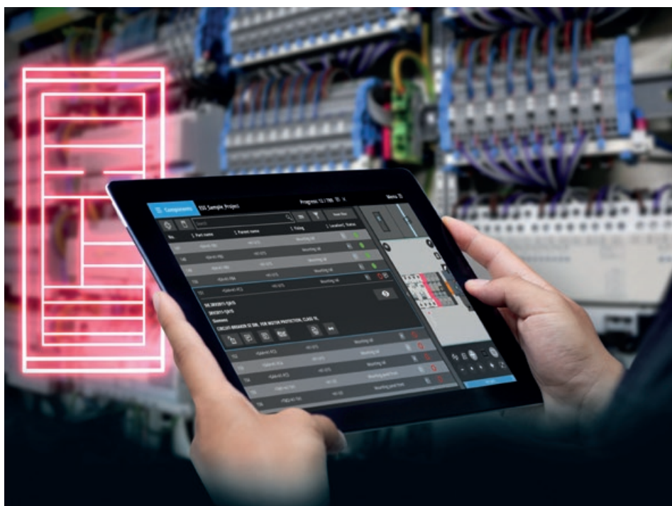
Figura 1. O novo sistema EPLAN Smart Mounting acelera a montagem de componentes no fabrico de armários de controlo.
