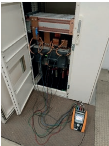
Figura 3. Montagem de um Analisador num Quadro Elétrico.
