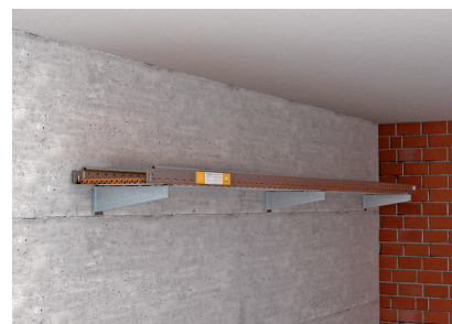
Montagem na parede.
