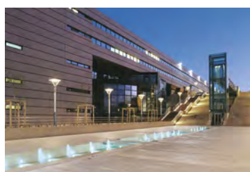
10. Áreas exteriores e estacionamento
