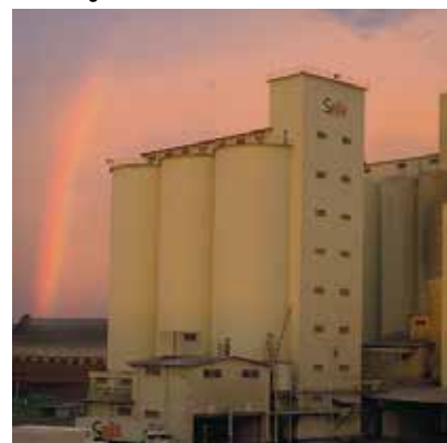
Silos de grãos
