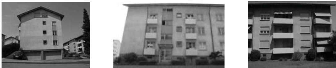
Figura 2. Caso de estudo 2 - Fachada a SE, NE e SW, respetivamente.
