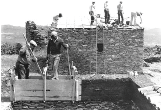
Figura 2. Técnica tradicional, construção em taipa.
