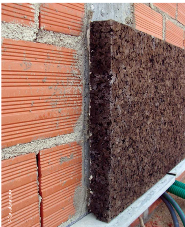
Aplicação de cortiça como isolante.
