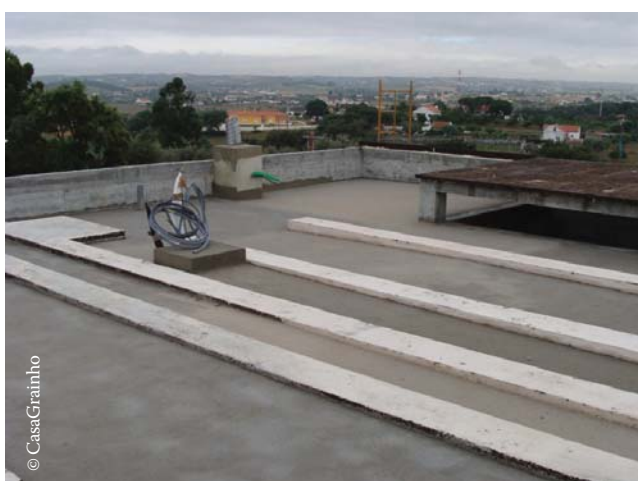
Isolamento da cobertura incluindo claraboia, vigas para a colocação de painéis solares e muro envolvente (nesta fase ainda sem cortiça)
