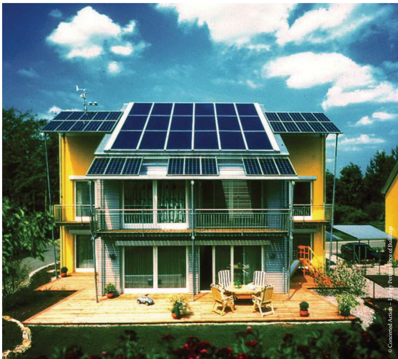
Casa pré-fabricada na Alemanha com energia de aquecimento zero.
