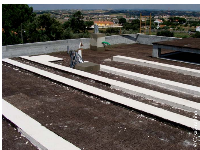
Isolamento da cobertura incluindo claraboia, vigas para a colocação de painéis solares e muro envolvente (nesta fase ainda sem cortiça)
