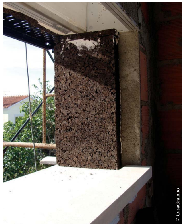
Isolamento de cortiça nos vãos das janelas e caixa de estores.
