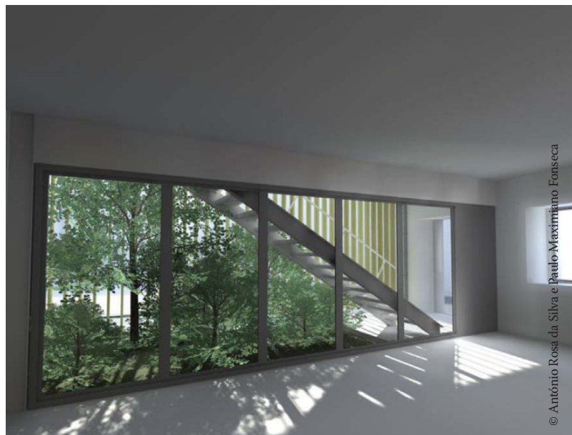
Vãos envidraçados sem caixa de estore e com proteção solar interior.
