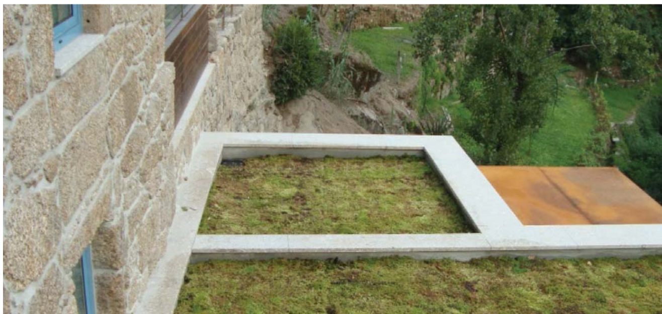
Cobertura ajardinada em Entre-os-Rios
