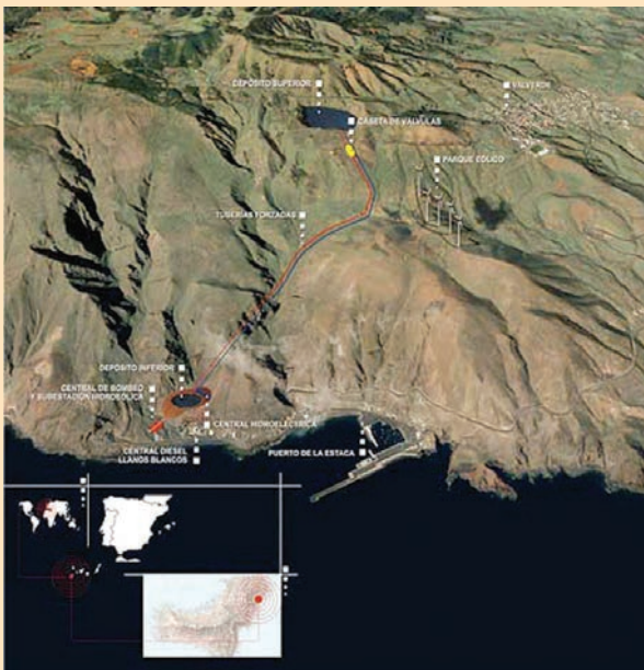
Panorama do projeto de energia renovável de El Hierro, onde é visível o reservatório inferior e a central hidroelétrica junto ao mar, bem como o reservatório superior e o parque eólico na parte mais elevada da colina. O reservatório superior terá uma capacidade de 556.000 metros cúbicos de água, que podem produzir energia suficiente para satisfazer as necessidades de eletricidade da ilha durante sete dias.
