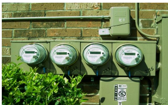
Figura 9.6: Instalação de medidores em unidades consumidoras residenciais.
