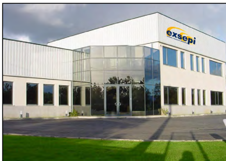
Fig. 2.1. Fachada principal da EXSEPI.
