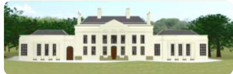
Edifício de referência
