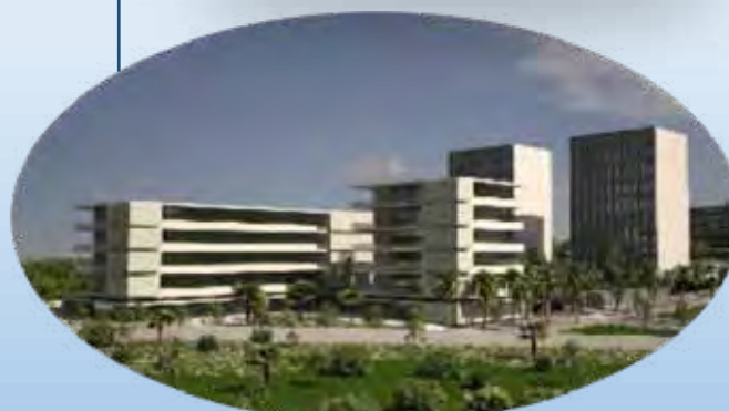
Edifício Njimbu Center – Angola (em execução) 51000m 2 de área de construção
