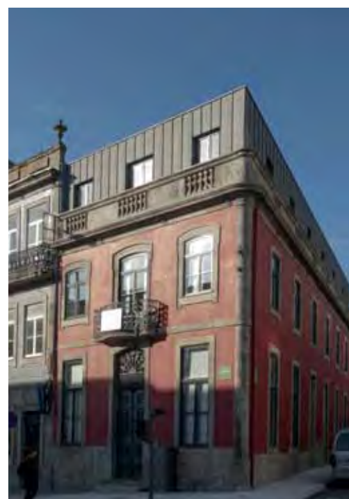
Edifício na Rua D. Manuel II
