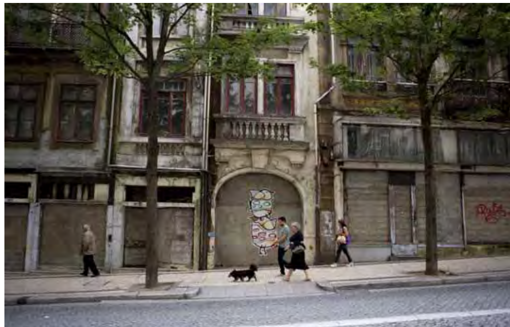
■ As obras para reabilitar parte do quarteirão D.João I, vulgarmente conhecido por Casa Forte, já estão no terreno
