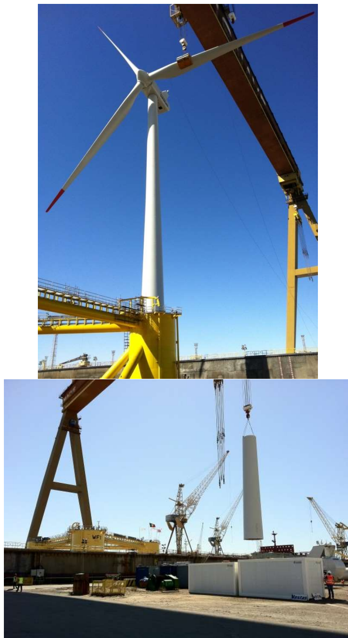
Fig. 1.2 - Montagem do sistema WindFloat na Lisnave
