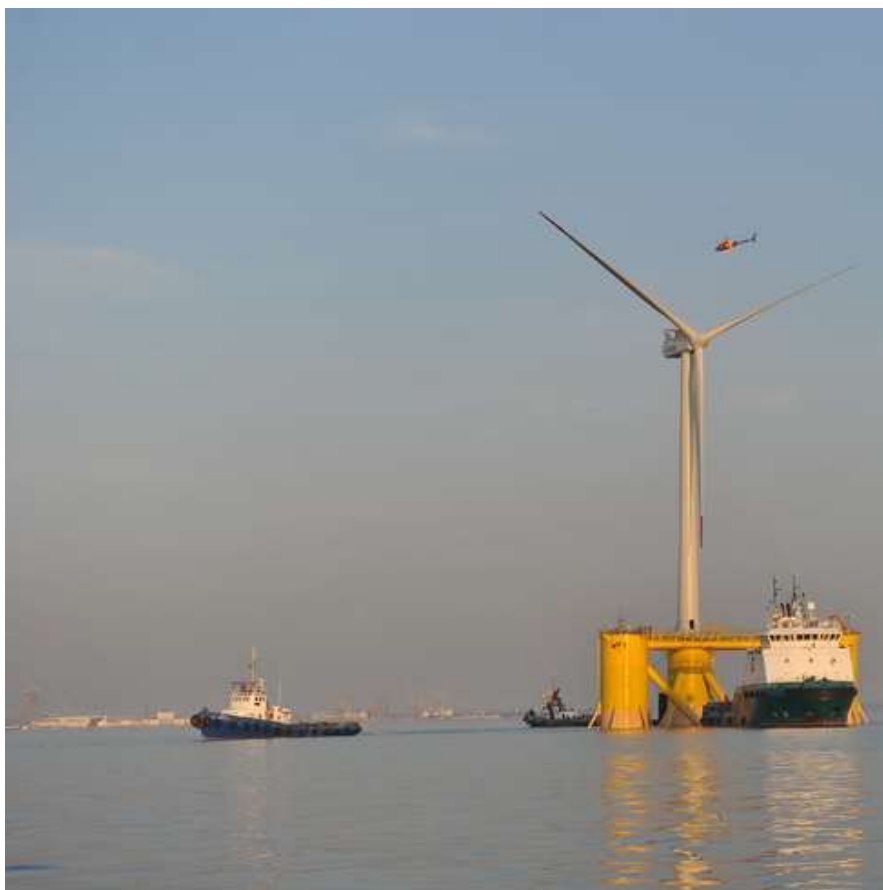
Fig. 1.6 – Sistema WindFloat® - eólico offshore flutuante [4].
