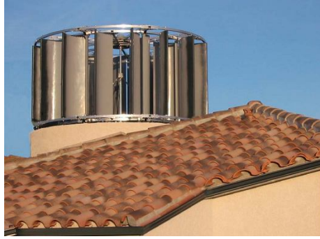
Fig.3.10. Turbina de eixo vertical – integração numa habitação [Gual, 2008].
