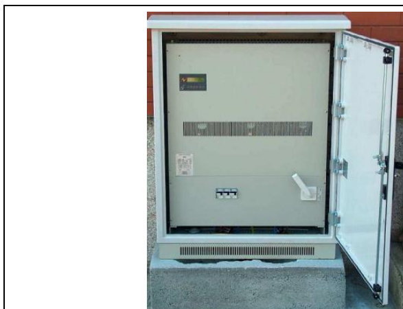
Figura 19 - Armário contendo regulador de fluxo
