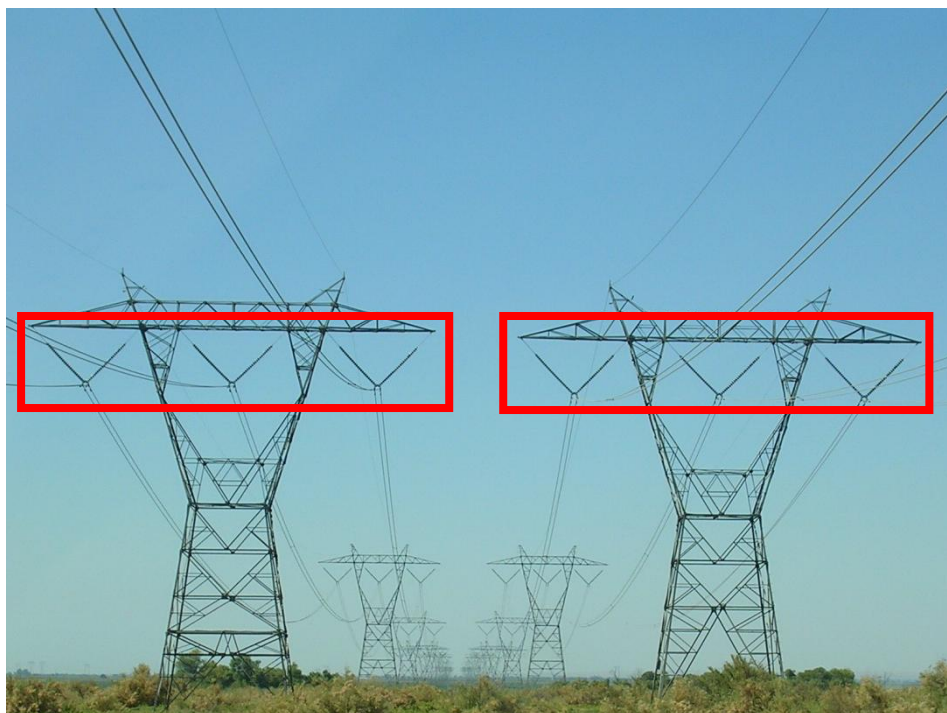
Figura 19 – Cadeias de isoladores de suspensão duplas em V
