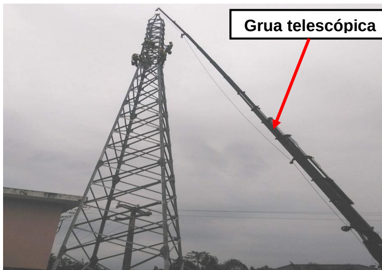
Figura 48 – Montagem das secções do apoio com grua telescópica
