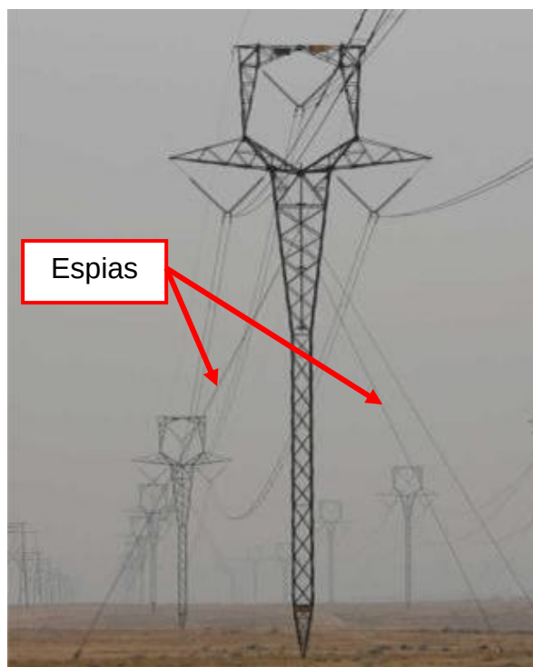
Figura 10 – Apoio espiado de uma LMAT
