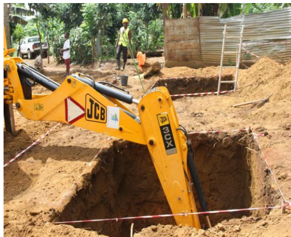
Figura 47 – Abertura de covas para maciços de fundação
