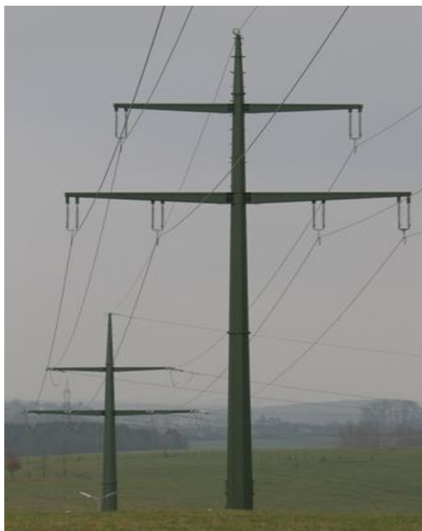
Figura 11 – Apoio poligonal de uma LMAT
