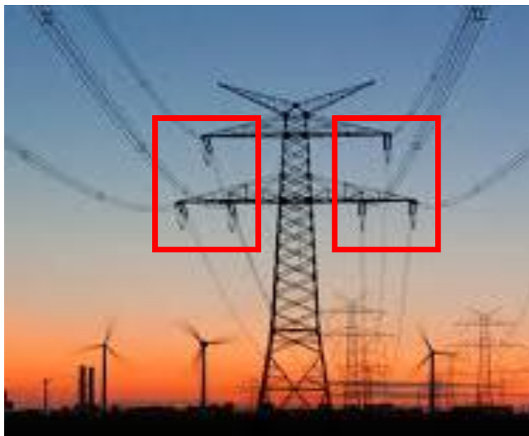
Figura 5 – LMAT com dois circuitos e disposição em triângulo
