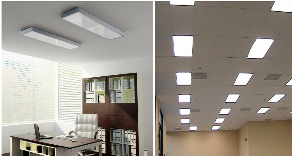
Figura 12 – Aparelhos de iluminação interior de montagem saliente (esquerda) e encastrados em tecto falso (direita)
