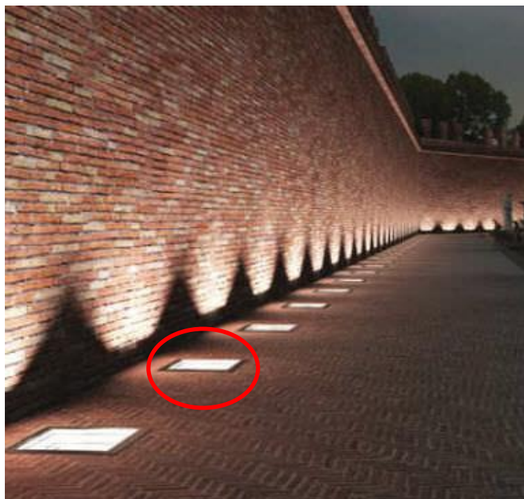
Figura 14 – Aparelhos de iluminação exterior encastrados no pavimento
