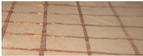
Construção de piso antiestático
