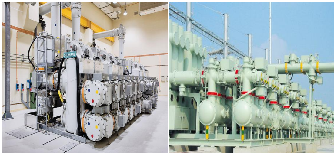
Figura 4 –Exemplos de GIS para montagem interior (esquerda) e para montagem exterior (direita)
