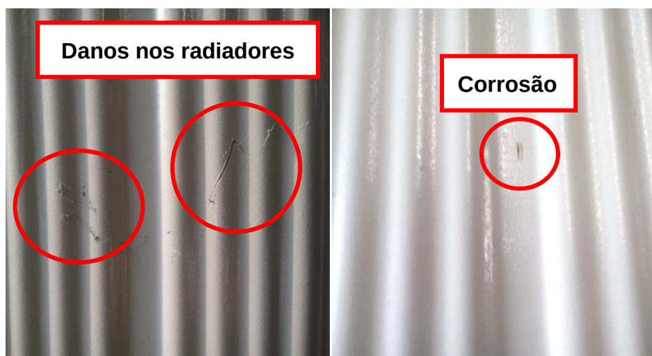
Figura 1 – Danos na cuba do transformador
