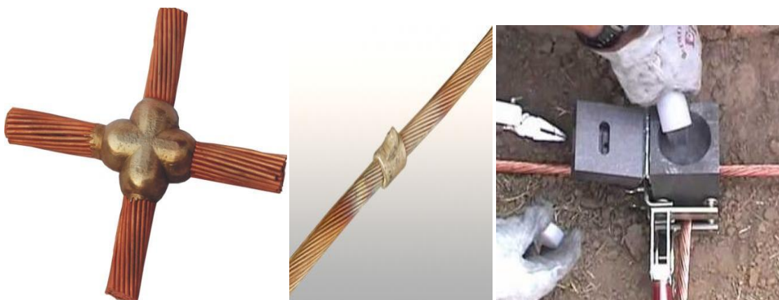
Figura 9 – Exemplos de soldadura aluminotérmica (esquerda e centro) e preparação da soldadura (direita)
