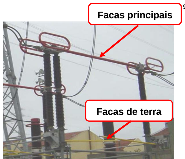
Figura 7 – Seccionador rotativo de corte vertical de duas colunas
