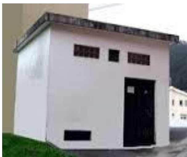
Figura 3 – Edifício para PT de cabina baixa
