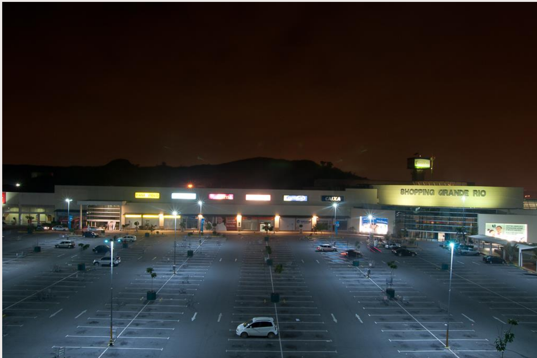
1ª ILUMINACAO DE LEDS EM ESTACIONAMENTO - RETROFIT
